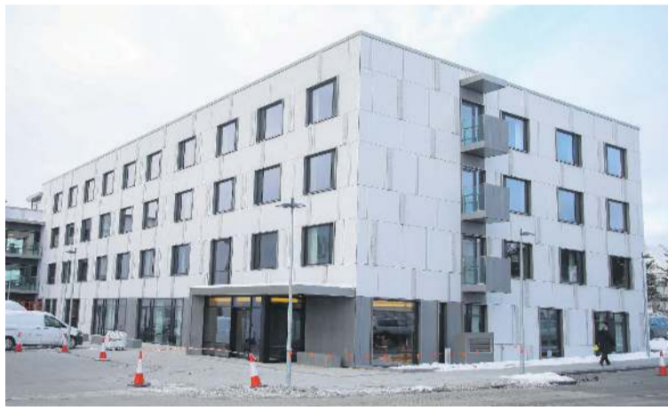
Nýja sjúkrahótelið var tekið í notkun 2019. Það er hluti af Hringbrautarverkefninu á vegum NLSH og er fyrsta byggingin sem tekin er í notkun í tengslum við það.
