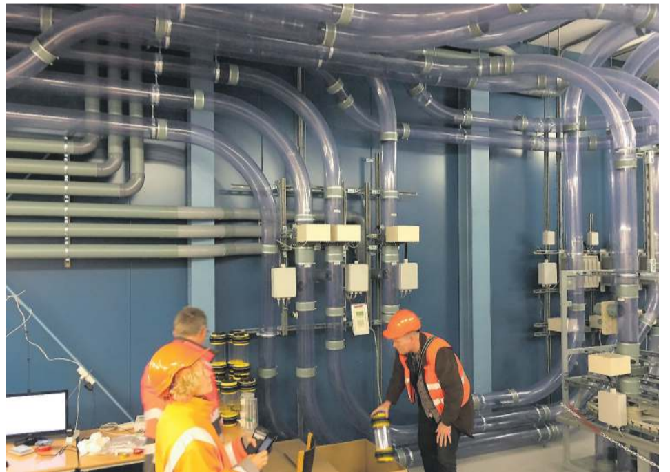
Hér má sjá rörakerfi uppsett á Skejby háskólasjúkrahúsinu í Árósum. Kerfinu er lýst sem metrö-lestarkerfi innanhússendinga á sjúkrahúsi og sparar mörg sporin.
