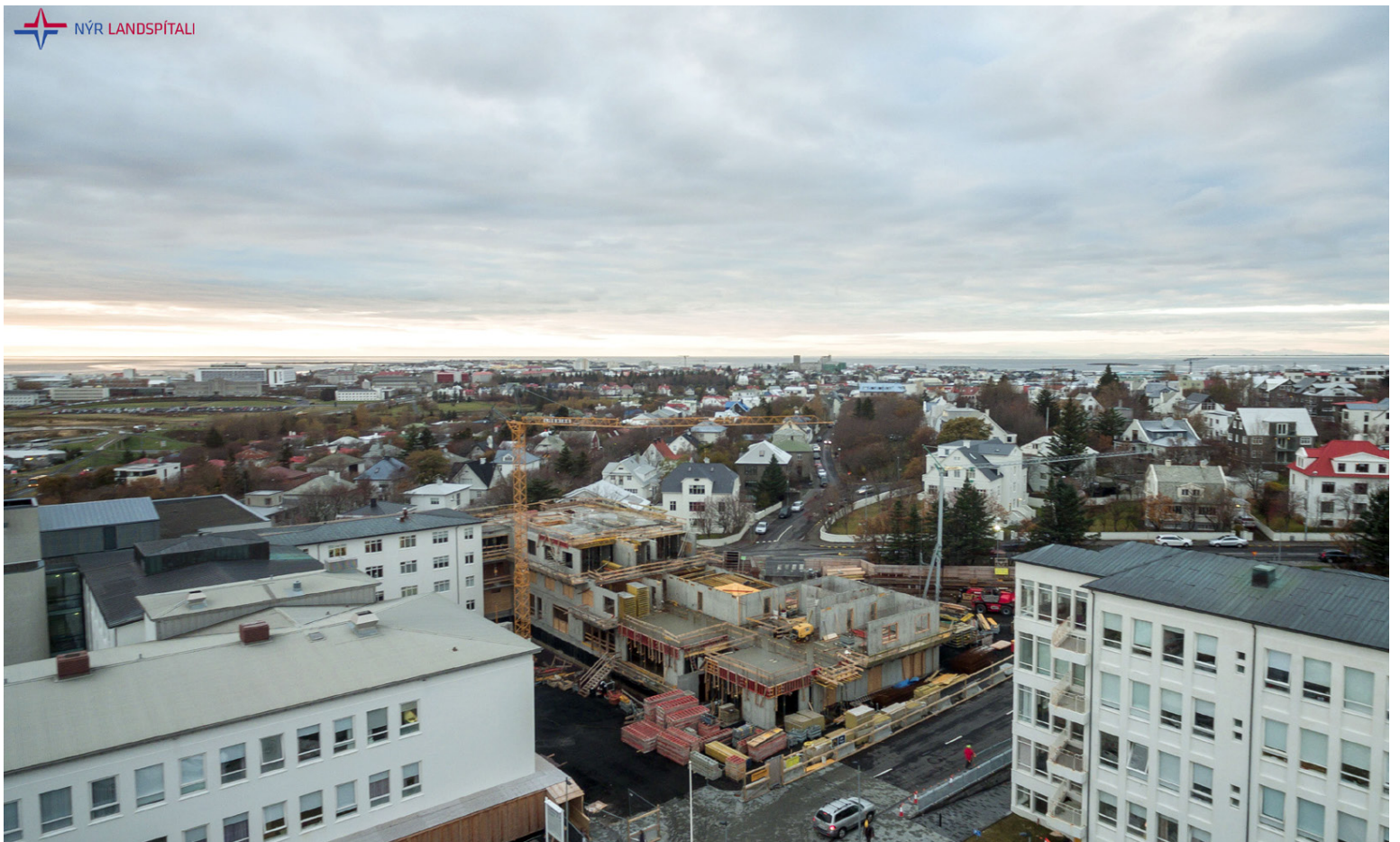
Stefnt er að því að byggingaframkvæmdum við nýjan spítala ljúki í árslok 2023. Hér er mynd af framkvæmdum við sjúkrahótel sem nú eru í fullum gangi.
